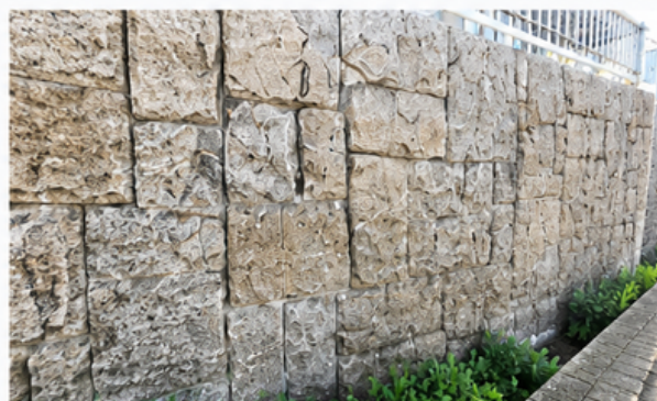
③施工後（明るくきれいに）
