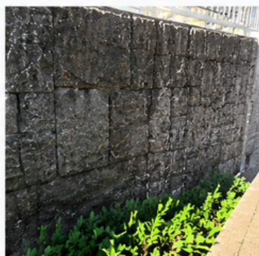
②引き（壁全体の状況）
